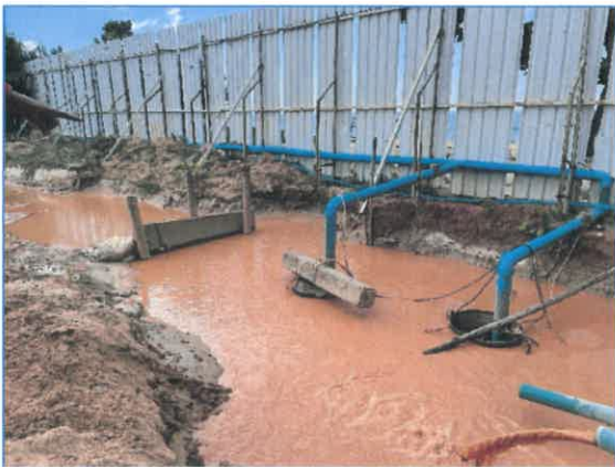
ภาพถ่ายที่ 2.1-2 ระบบระบายน้ำชั่วคราวภายในพื้นที่ก่อสร้าง
