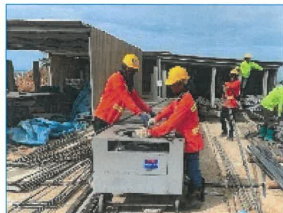
ภาพถ่ายที่ 2.1-15 เครื่องตัด/ดัดเหล็กที่ใช้ระบบไฟฟ้า แทนเครื่องจักรที่ใช้ น้ำมัน
