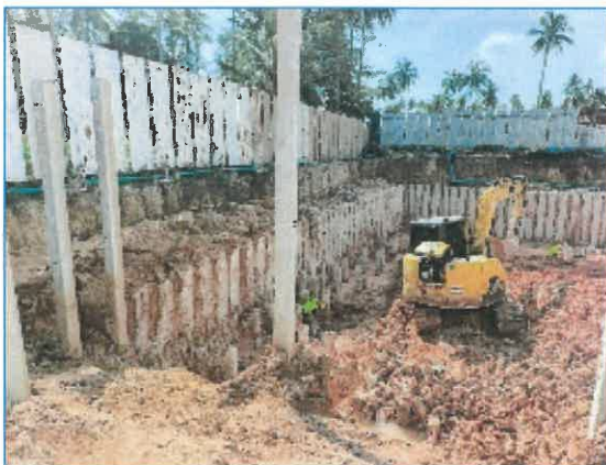
ภาพถ่ายที่ 2.1-1 pile wall ที่ออกแบบตามหลักวิศวกรรมเพื่อป้องกันการพังทลายของดิน
