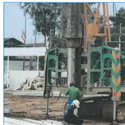
การใช้หมอนรองเสาเข็มที่อ่อน เพื่อลดแรงสั่นสะเทือน
