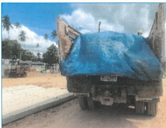
ภาพถ่ายที่ 2.1-9 ผ้าใบปิดคลุมรถบรรทุกขนส่ง
