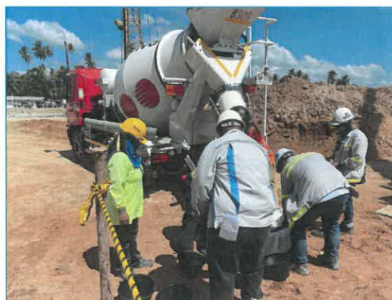
ภาพถ่ายที่ 2.1-16 รถขนส่งปูนผสมสำเร็จ แทนการผสมปูนในที่
