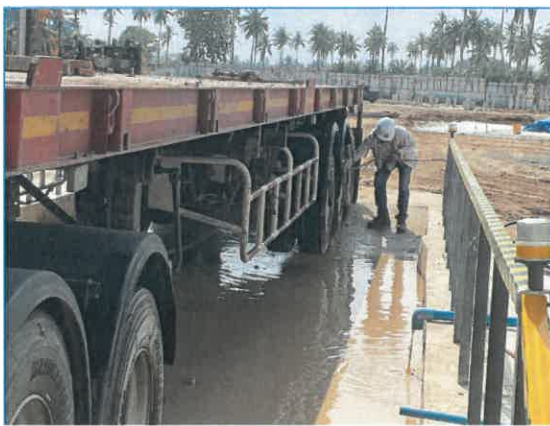
ภาพถ่ายที่ 2.1-8 จุดล้างล้อรถก่อนออกจากโครงการ
