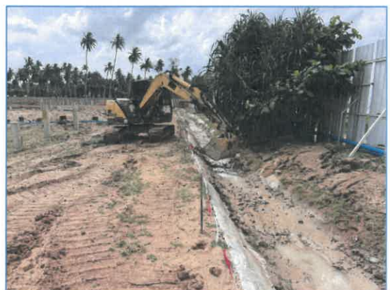
ภาพถ่ายที่ 2.1-23 การขุดลอกตะกอนดิน
