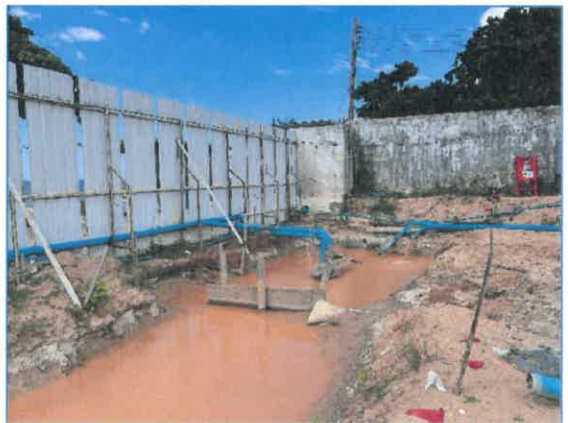
ภาพถ่ายที่ 2.1-2 ระบบระบายน้ำชั่วคราวภายในพื้นที่ก่อสร้าง
