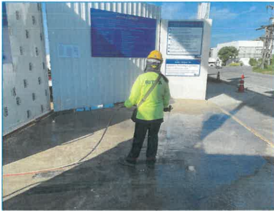
ภาพถ่ายที่ 2.1-7 การฉีดพรมน้ำและล้างทำความสะอาดบริเวณทางเข้า-ออกโครงการ
