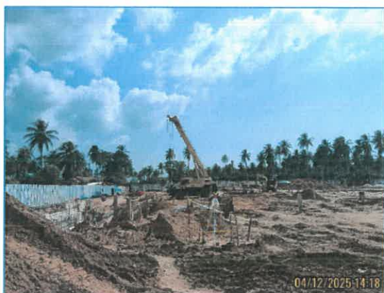
ภาพถ่ายที่ 2.1-37 mobile Crane ที่ใช้ในการก่อสร้าง
