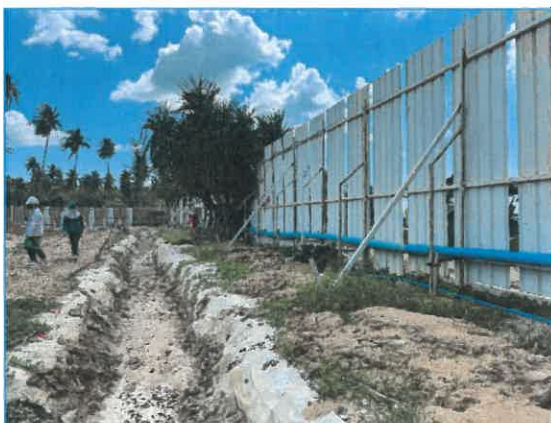
ภาพถ่ายที่ 2.1-2 ระบบระบายน้ำชั่วคราวภายในพื้นที่ก่อสร้าง
