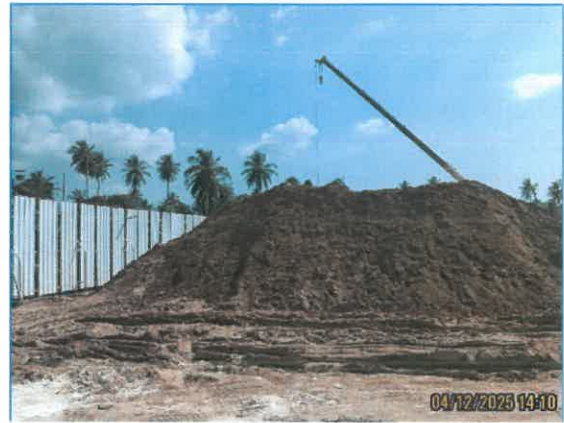
ภาพถ่ายที่ 2.1-3 การกองดินเฉพาะในพื้นที่ก่อสร้าง
