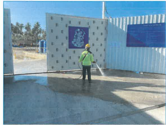
ภาพถ่ายที่ 2.1-7 การฉีดพรมน้ำและล้างทำความสะอาดบริเวณทางเข้า-ออกโครงการ
